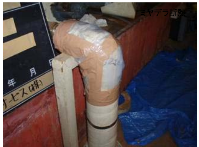
切断部保温材撤去
