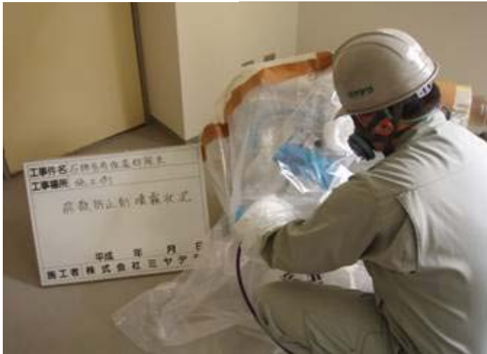
再度飛散防止液 浸透
