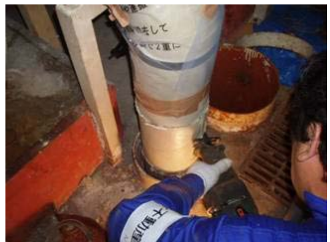
切断部保温材撤去
