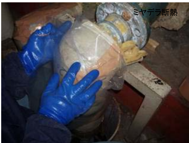
切断部 保温材撤去
