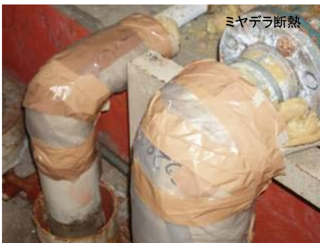
切断部 保温材撤去
