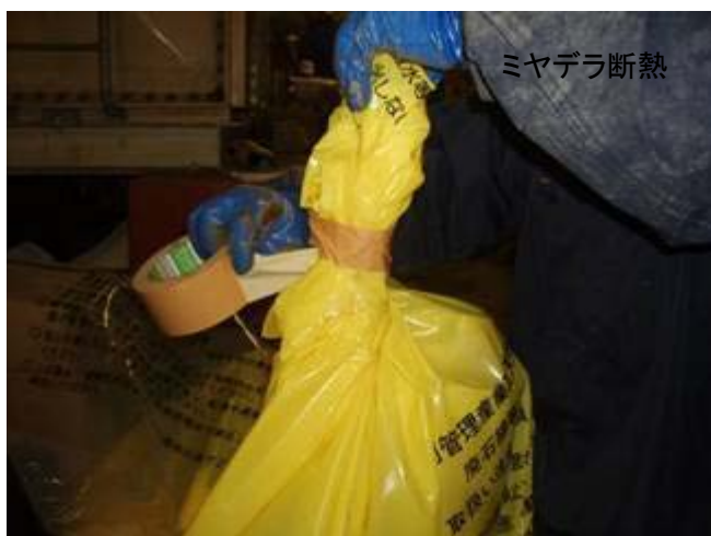
廃アスベスト処理用梱包 2 層目ねじり
