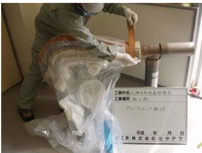
グローブバッグ取り付け作業
