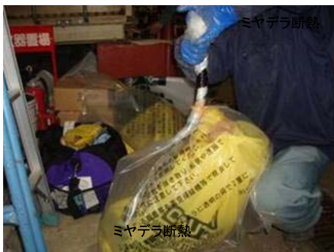
廃アスベスト処理用梱包 2 層目ねじり
